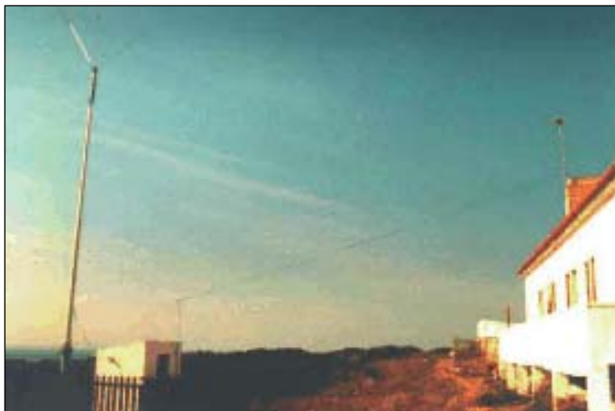
Fig. 1 – Imagem das antenas da estação DGPS experimental instalada no Cabo Espichel. À direita, montada na chaminé do edifício, vê-se a antena GPS, enquanto à esquerda se pode ver a antena transmissora do radiofarol, neste caso convertida para a transmissão das correcções DGPS.
