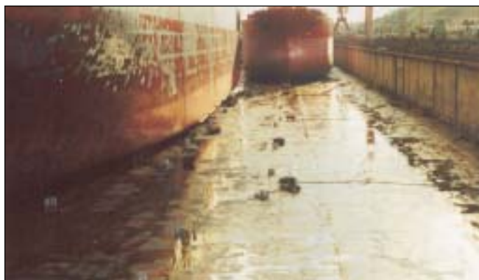
Fig. 3 – Vista da doca seca n.º 13 da Lisnave
