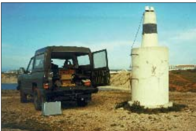
Fig. 6 – Gravando dados no marco geodésico de Sagres
