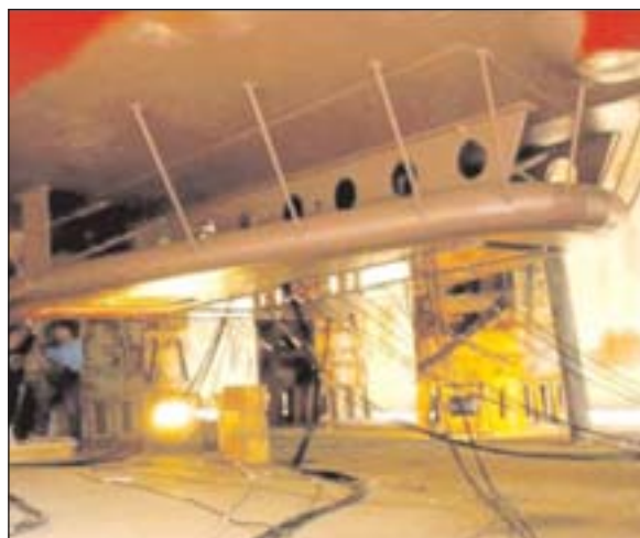
Montagem da gôndola no NRP «D. Carlos I»
