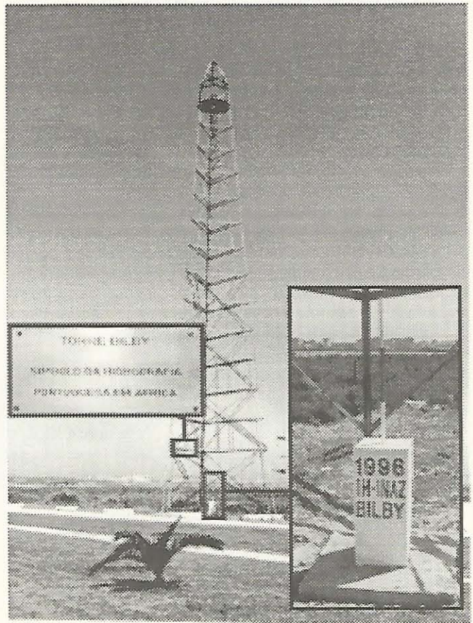
- Torre Bilby - Instalações Navais da Azinheira
