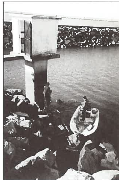
Inspecção do poço do marégrafo.
