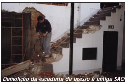
Demolição da escadaria de acesso à antiga SAO
