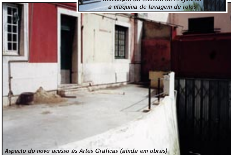
Aspecto do novo acesso às Artes Gráficas (ainda em obras)
