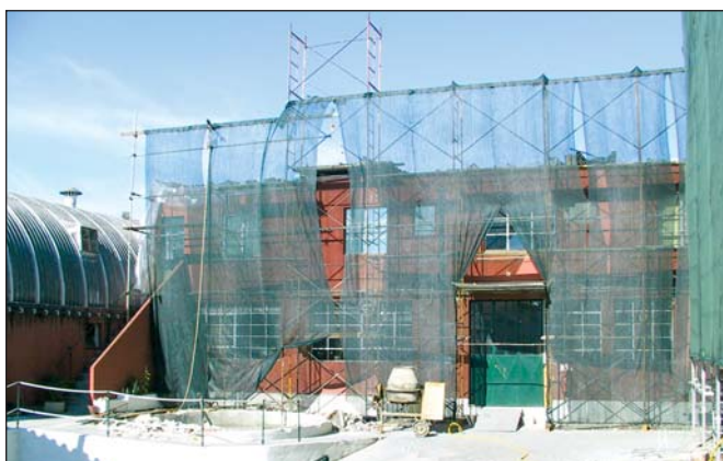
Início das obras
