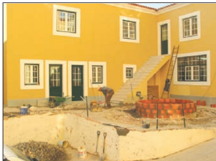
Construção do novo pavimento junto às Artes Gráficas
