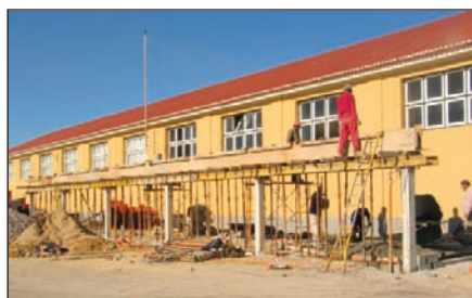
Construção do Novo Laboratório de calibração – Exterior
