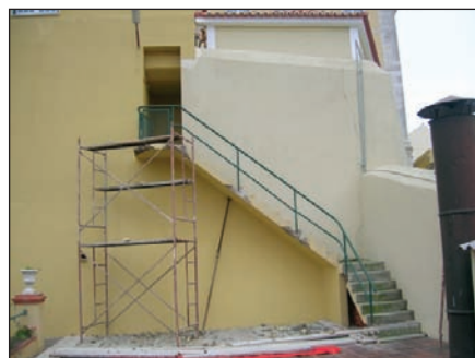
Obras da escada de acesso ao parque de viaturas
