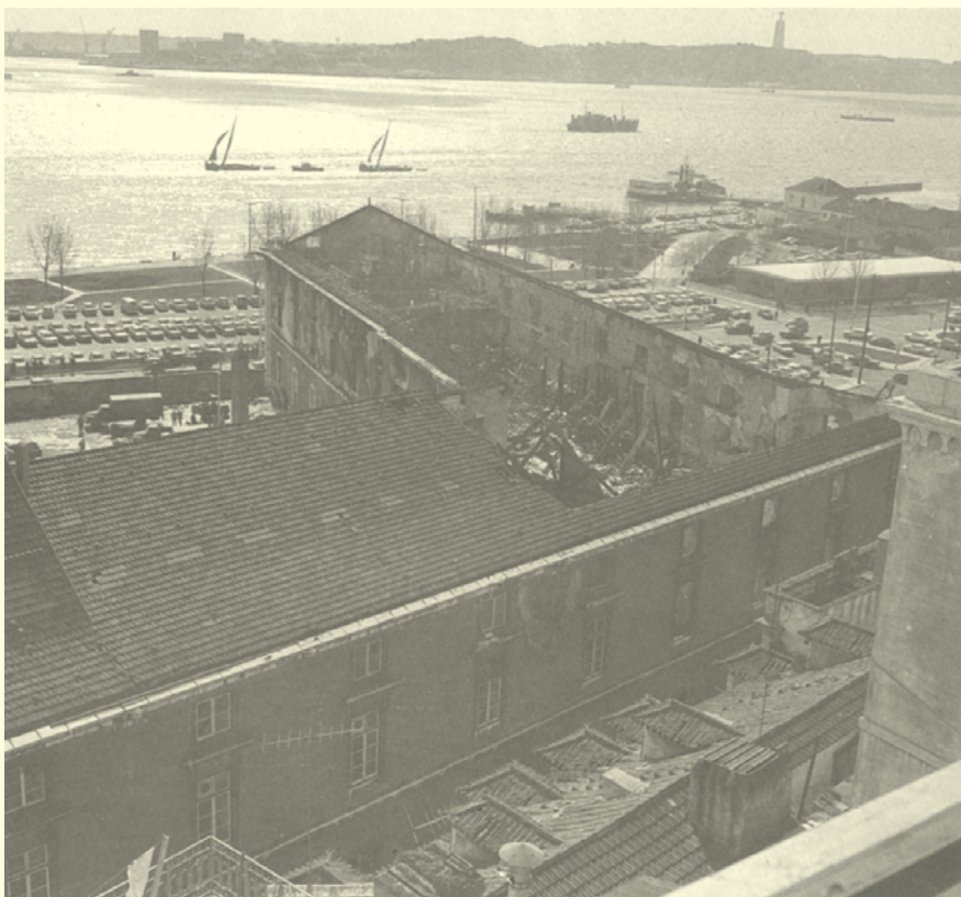
O incêndio devorou por completo as instalações do Instituto Hidrográfico, situadas junto ao Largo do Corpo Santo
