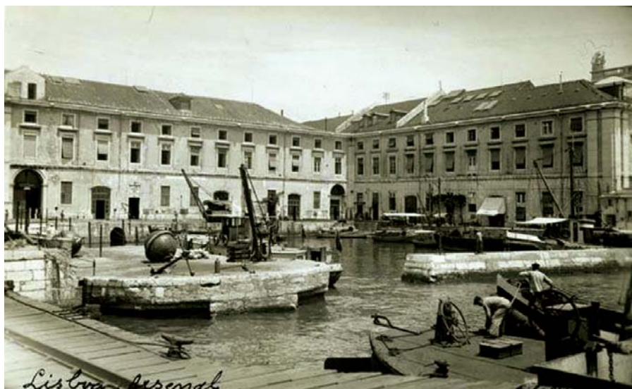
A gravura descreve a azáfama na doca do Arsenal da Marinha. À esquerda, pode observar-se uma «bóia cega», habitualmente utilizada para protecção das bóias ODAS.
