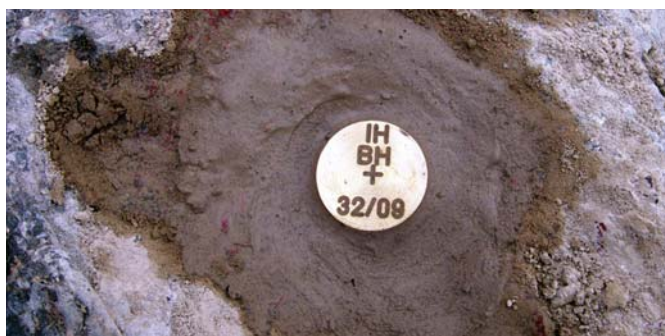
Fig. 8 - Marca de nivelamento "IH BH 32/09"
