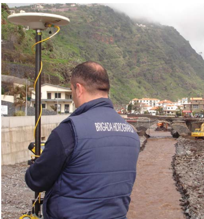
Levantamento topográfico na Ribeira Brava
