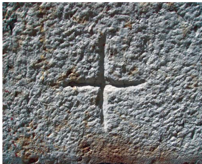
A cruz constitui a inscrição mais recorrente nas paredes do edifício.
