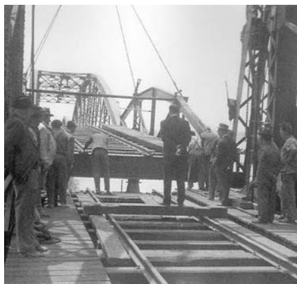
Desmontagem da ponte sobre o rio Coina.
