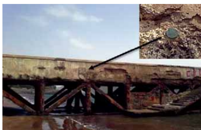
Única marca de nivelamento existente na Praia: MHACV 1946 no cais da Alfandega.
