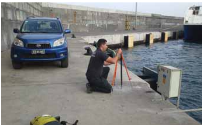
Instalação de um marégrafo (Furna)
