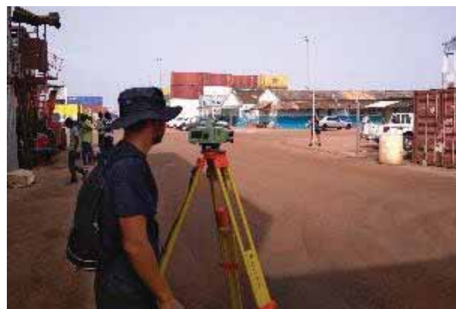
Realização de nivelamento geométrico em Bissau.
