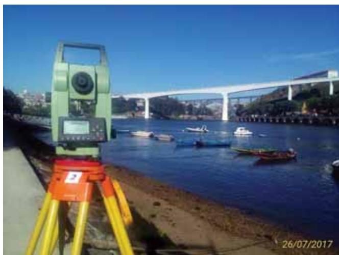
Topografia da ponte do Freixo.
