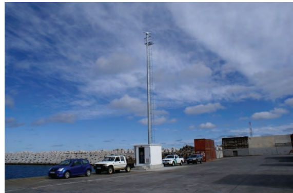
Figura 4 – Torre e instalações do radar de banda X no porto da Praia da Vitória para a monitorização da agitação marítima periférica.
