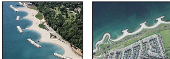
Fig. 2. Exemplos de aplicação de estruturas de contenção e estabilização de praias – Lake Forest Beach, Illinois, EUA(esq.) e Toronto, Canadá (dir.). Fonte:Google Earth.
