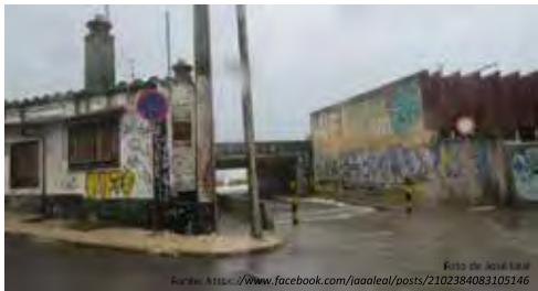
Fig. 4. Inundação de origem oceânica na Av. Ferreira Godinho, Cruz Quebrada, no dia 02/03/2018.
